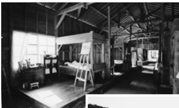
洋小屋組の洒落た兵舎。 内部も見学できる
