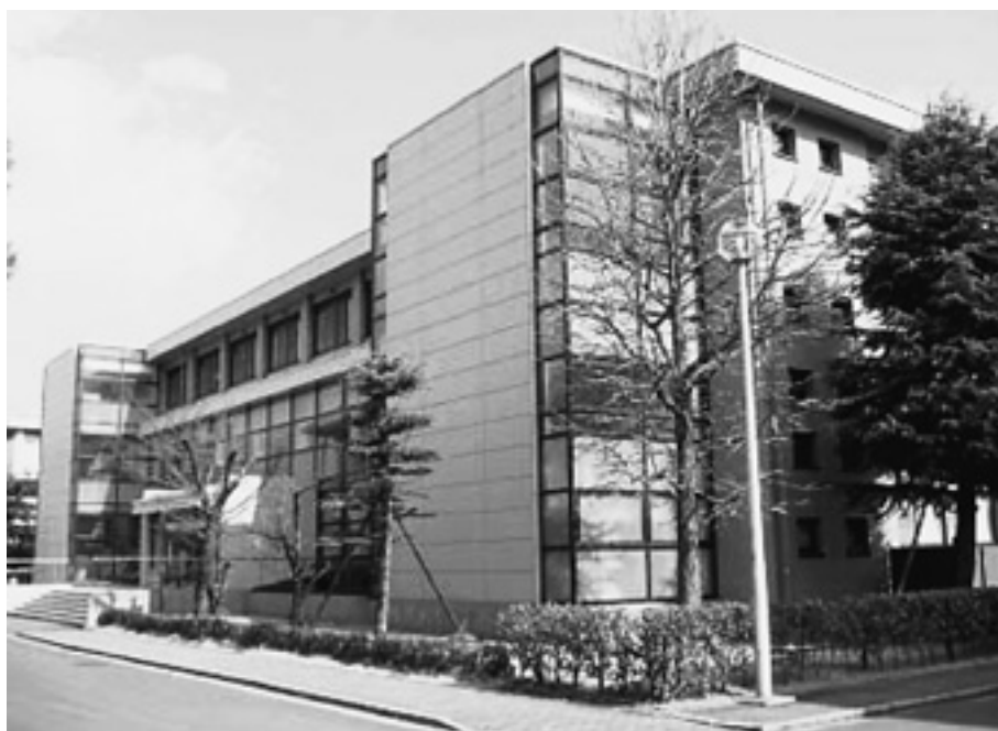
総合科学部 3号館
